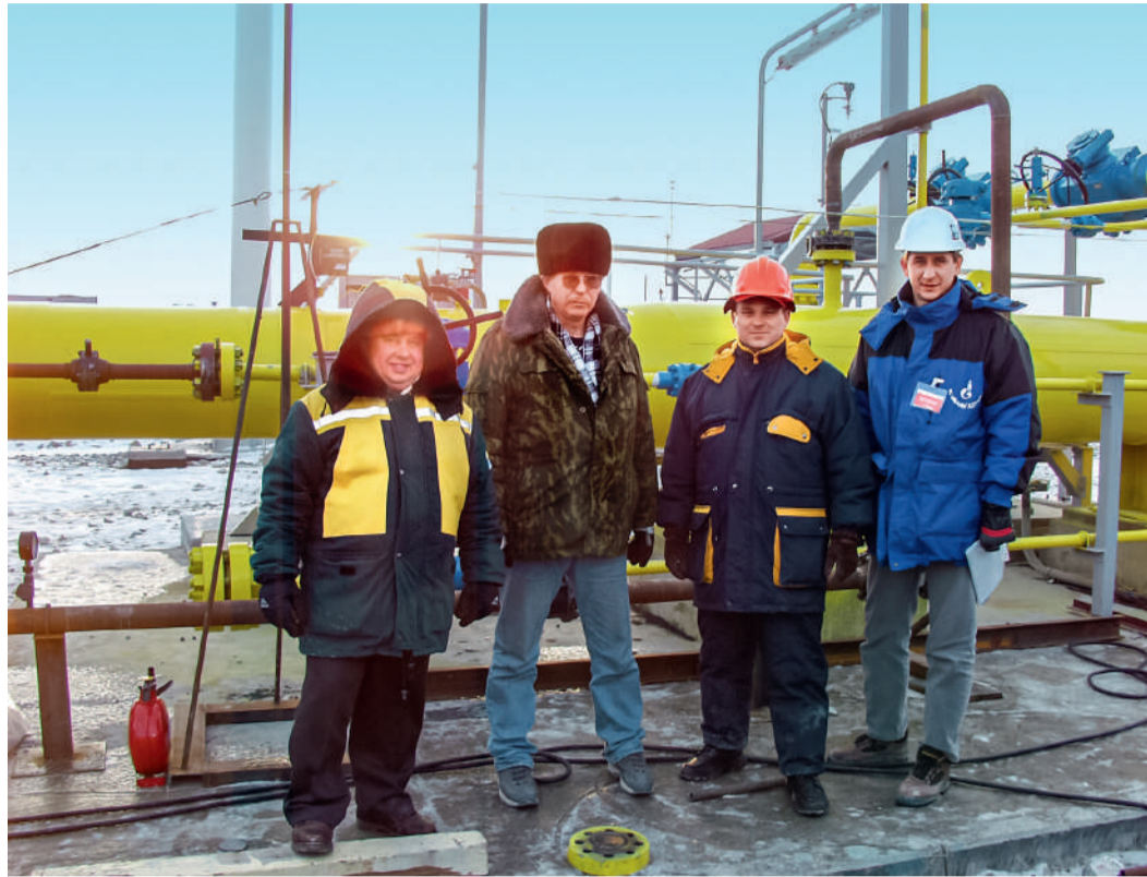
Пуск газопровода «Голубой поток». Декабрь 2002 г.
