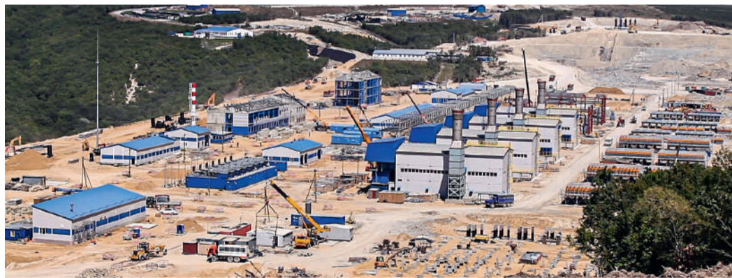
Фото из архива. Строительство КС «Русская»
