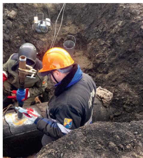
Работам на КС «Майкопская» предшествовала тщательная подготовка объекта и его обследование. Специалисты Смоленского УАВР собирали исходные данные с уточнением места врезки, кольцевых сварных швов, толщины стенок и диаметра трубопровода. Был составлен и утвержден подробный план производства работ, и только потом газовики приступили к выполнению ответственной задачи.
