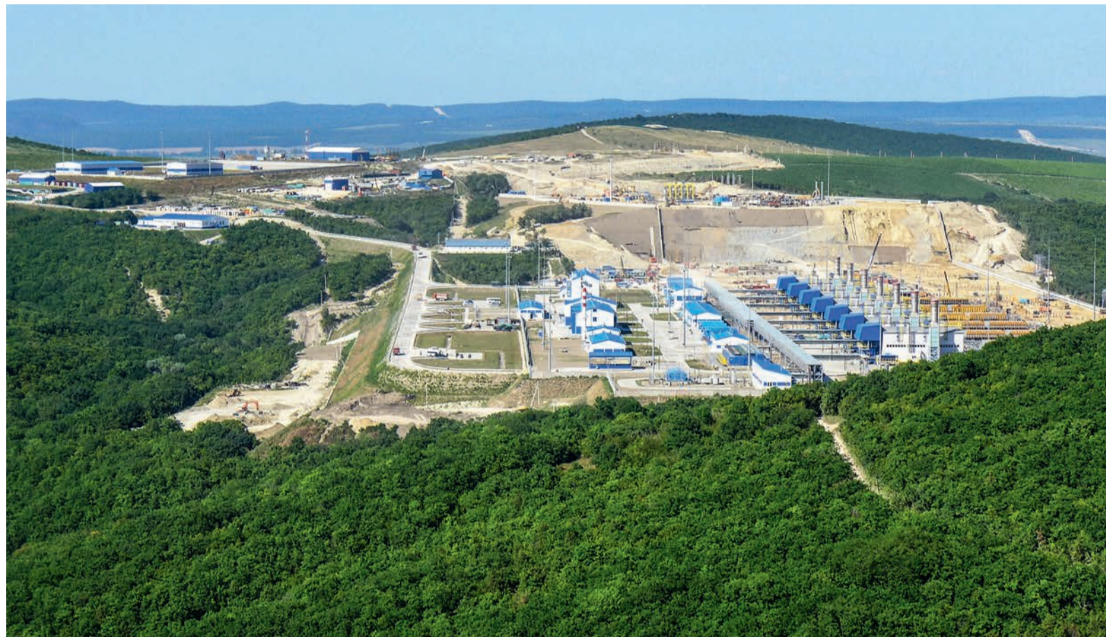
КС «Русская» – головная компрессорная станция будущего газопровода «Турецкий поток»
